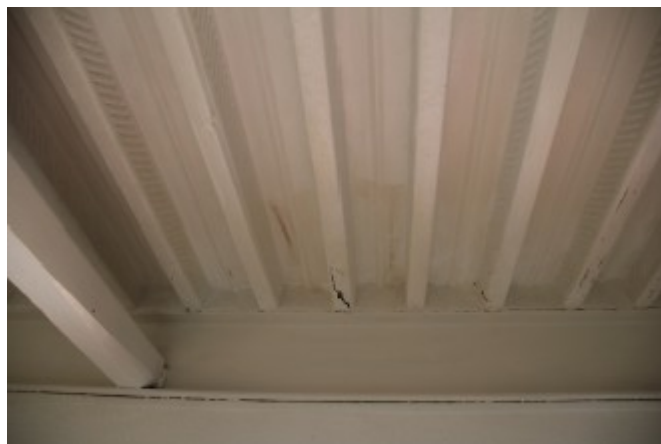
Détail du plafond en salle
