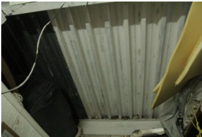
Bac acier en bon état
